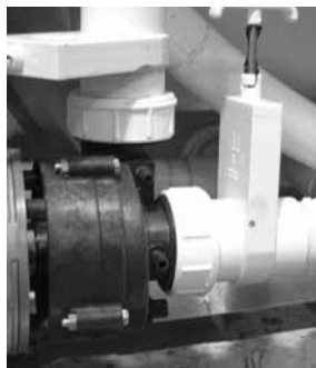
Vanne guillotine et raccord-union de la pompe
