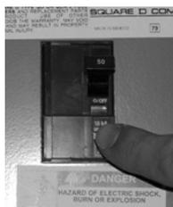
*Le disjoncteur GFCI doit se situer dans un boîtier étanche à proximité du spa, à une distance maximale de 5 pieds (1,5 mètre).*
